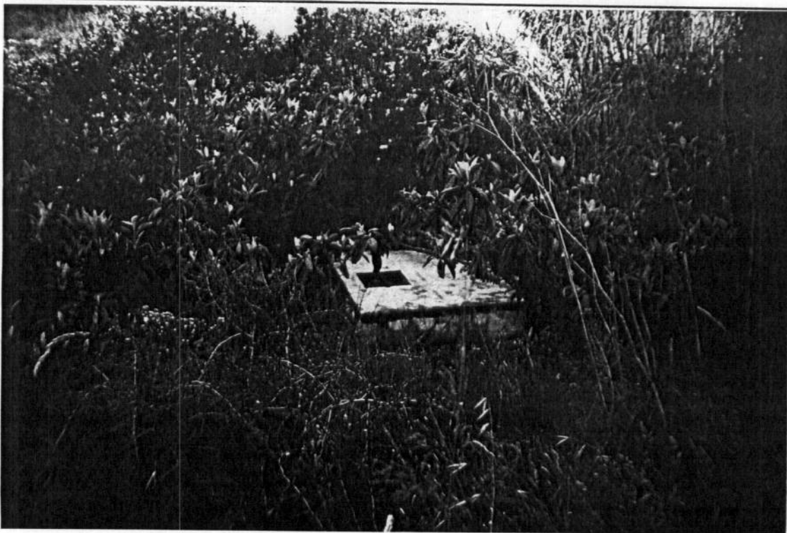
VISTA DE DETALLE
